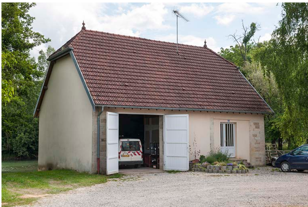
Garage et logement (ancien atelier de scierie).
