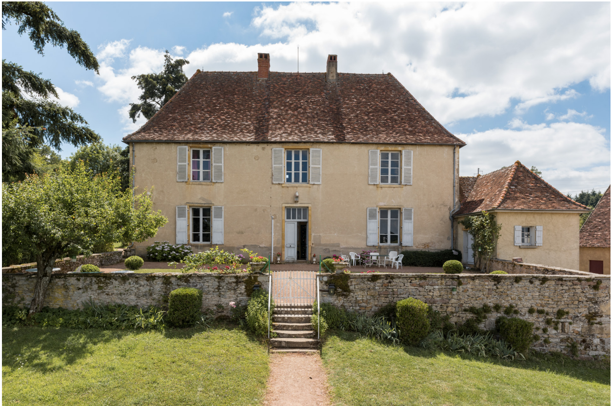
Façade antérieure du logement
