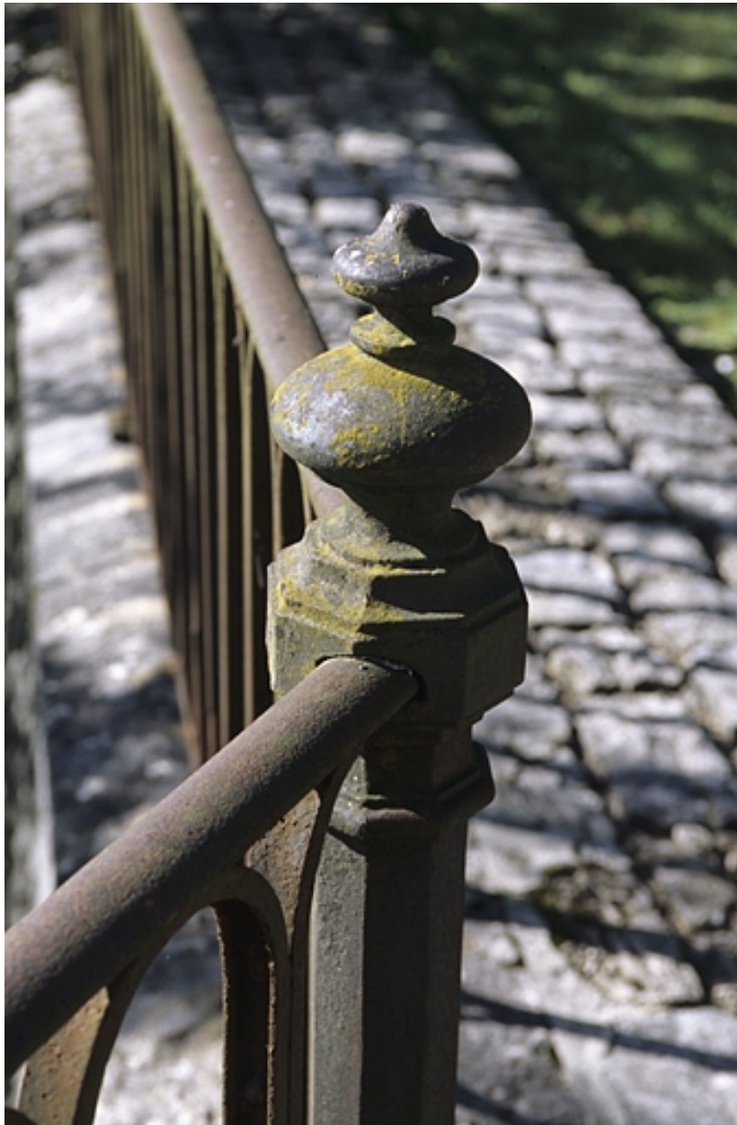
Motif d'amortissement d'un potelet du garde-corps.
