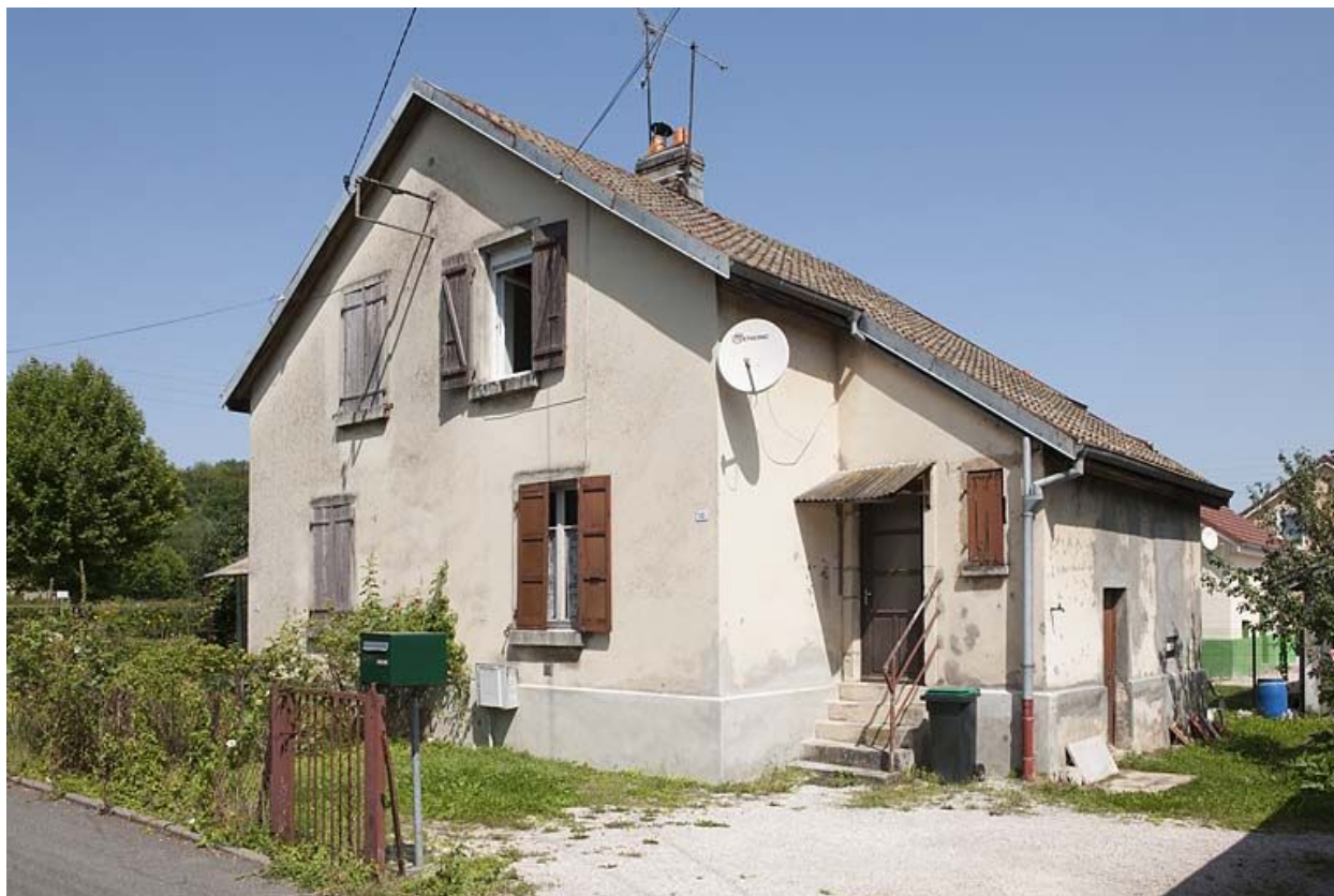
Maison jumelée vue de trois quarts droite.
