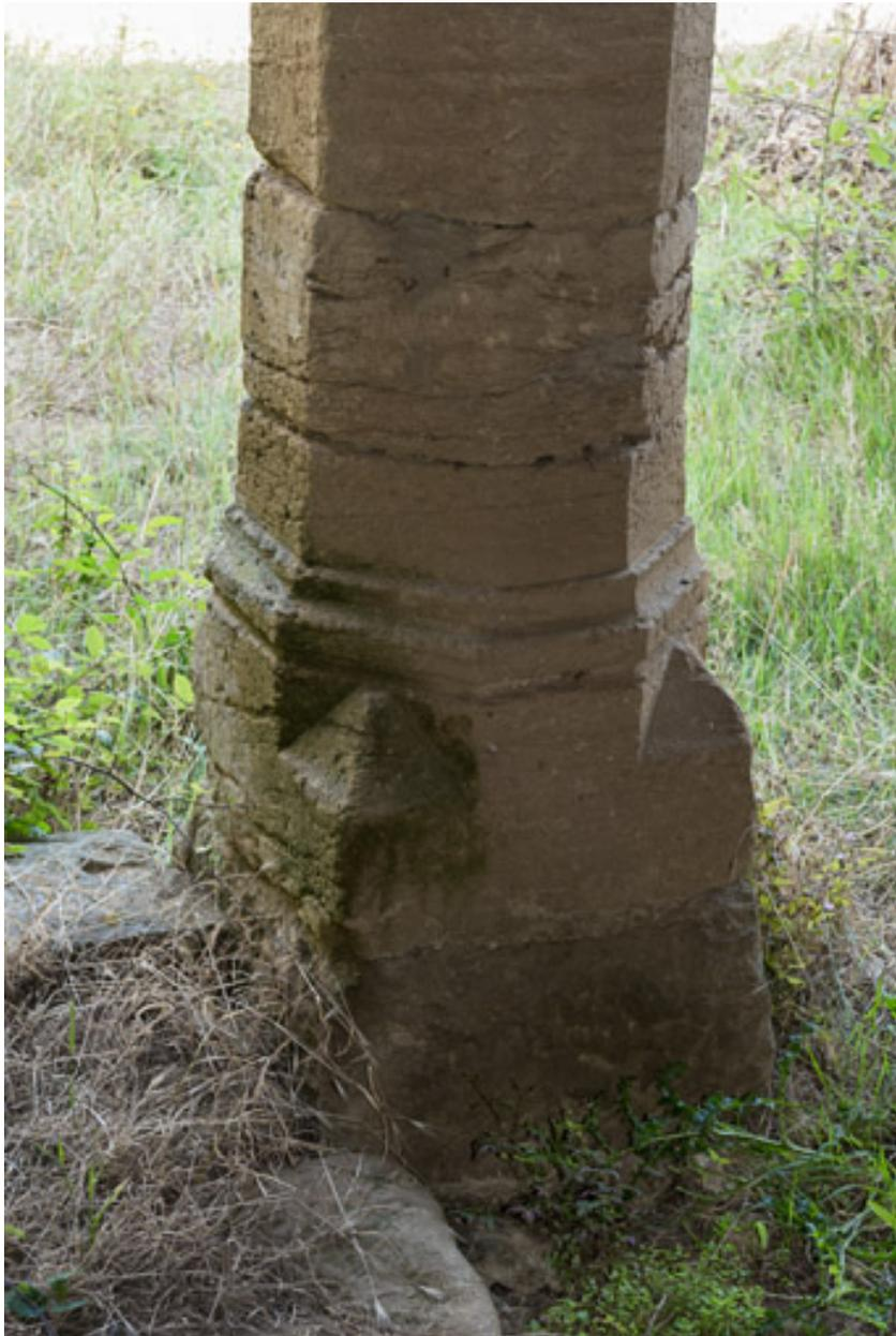
Une des poutres du plancher du fenil est soutenu par ce pilier hexagonal, avec une base moulurée, utilisé en remploi.
