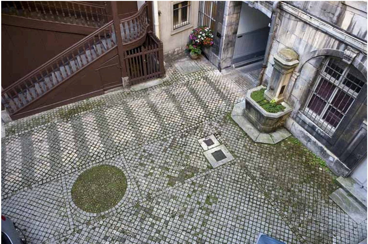
Détail du pavage de la première cour depuis l'escalier droit.
