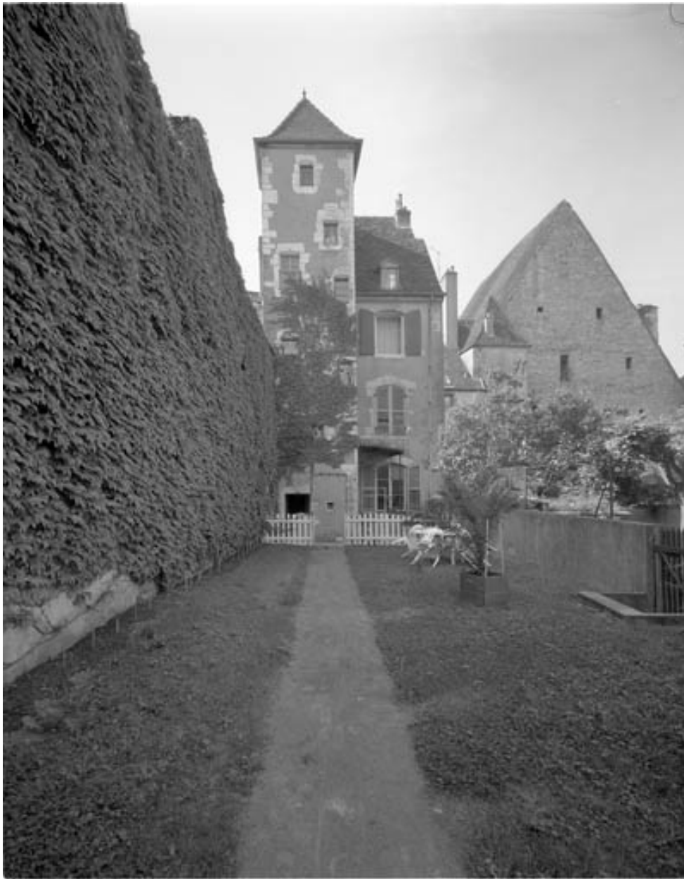
Façade postérieure du n° 8 de la rue du Marché, avec la tour Saint Pierre Fourier, et la façade postérieure du grenier à blé.
