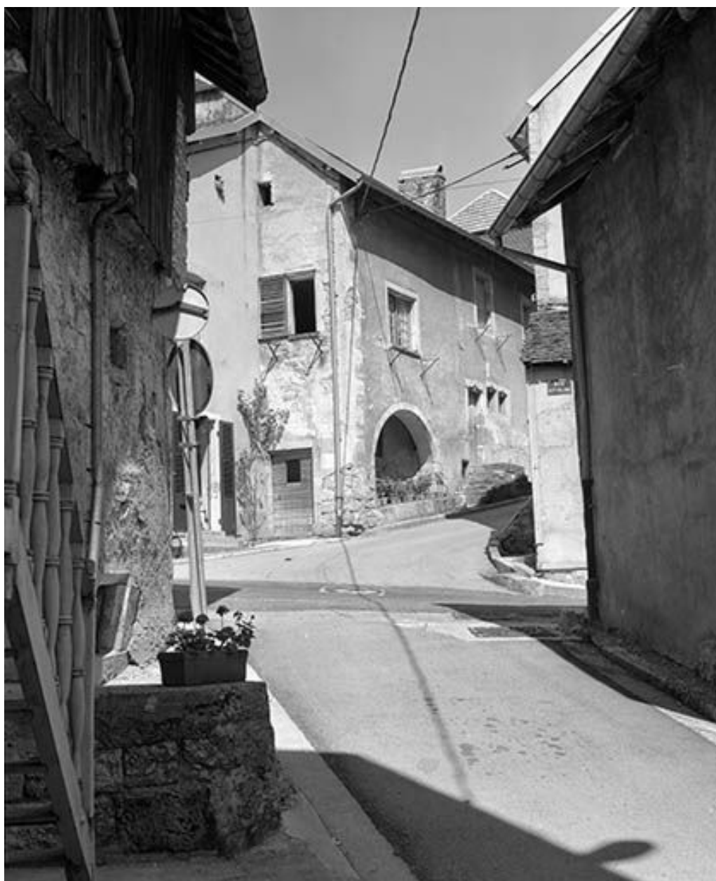
Façades antérieure et latérale gauche.
