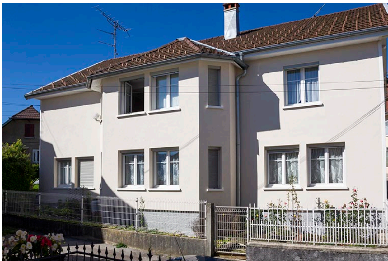
Façade latérale gauche.
