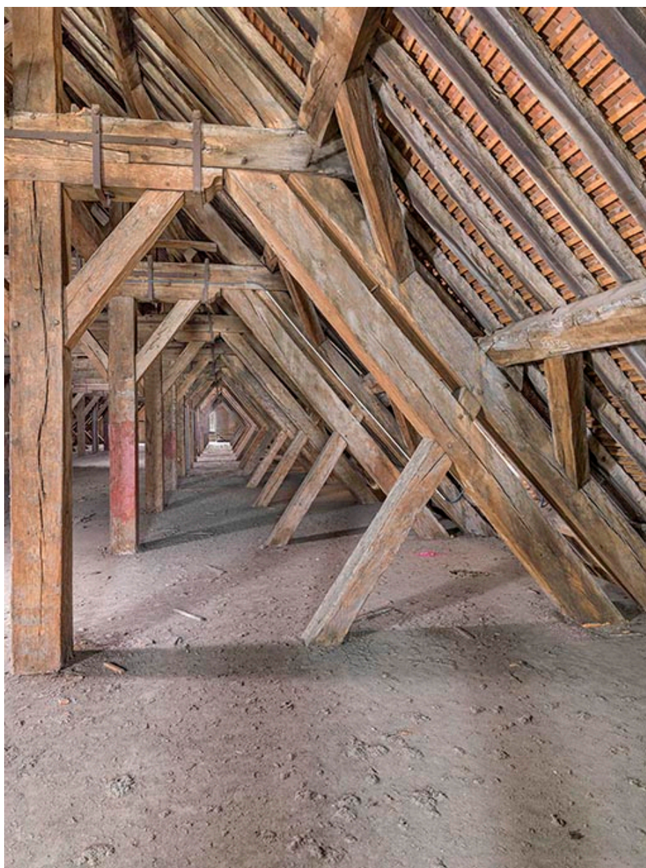
Détail de la charpente à chevrons-portant-fermes.
