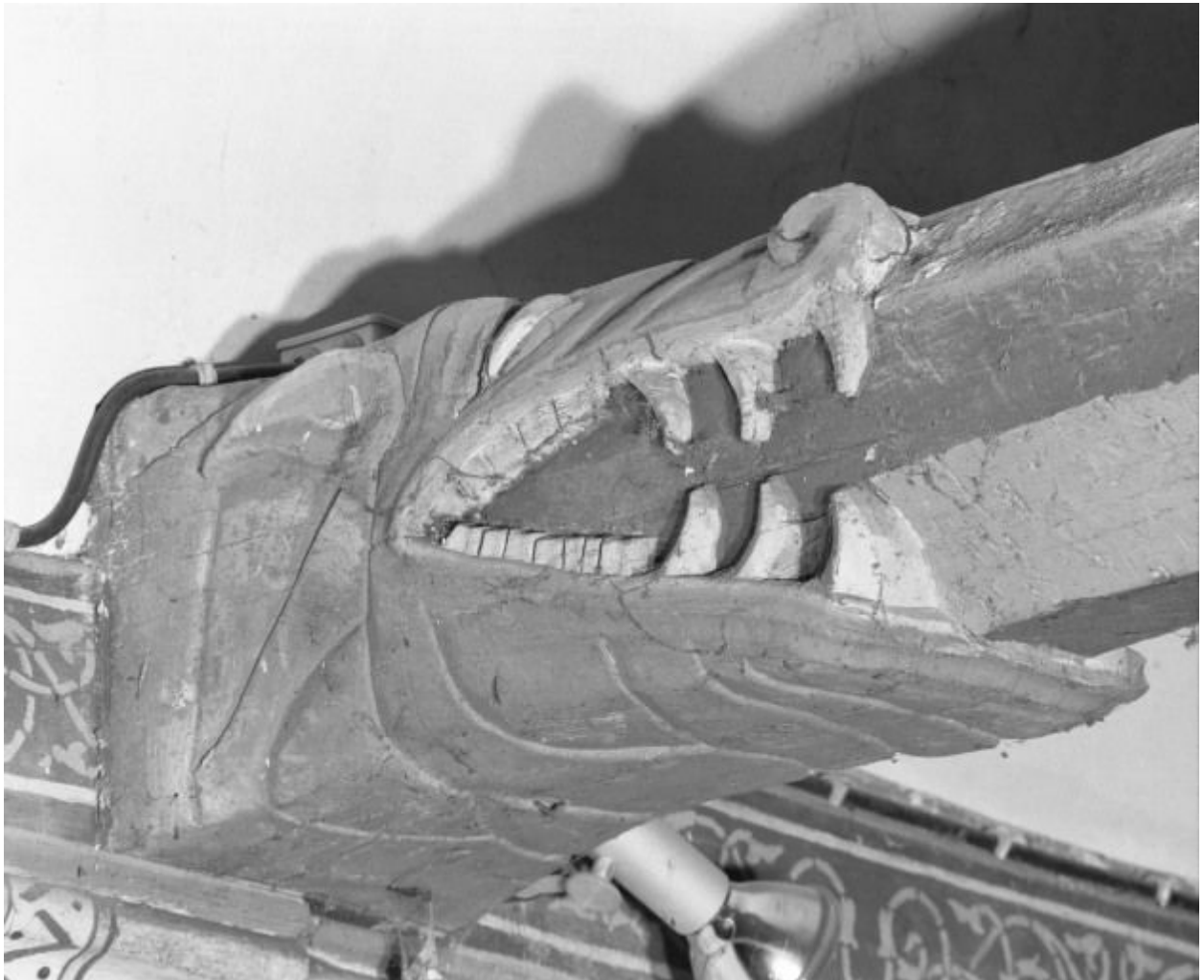
Charpente de la nef, engoulant gauche du 3ème entrain
