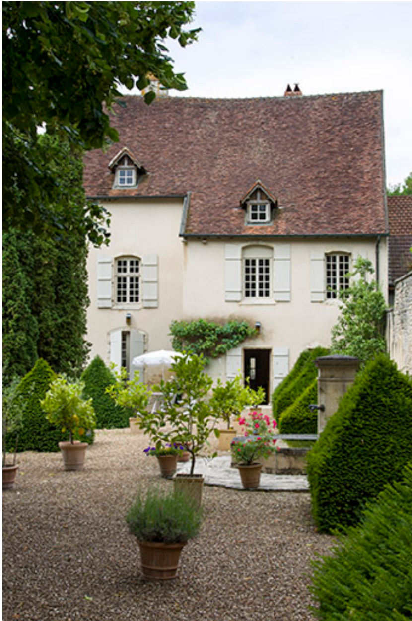
Façade postérieure donnant sur le jardin.
