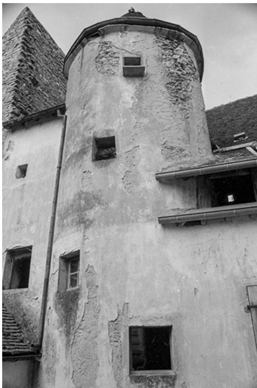
Tourelle d'escalier avec pigeonnier au dernier étage.
