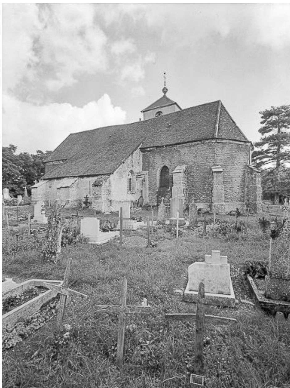
Façade latérale droite vue depuis l'est.
