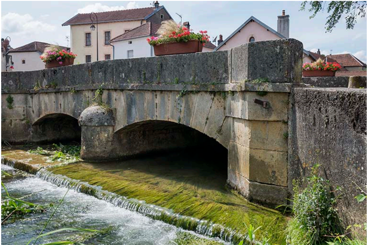
Face sud, vue depuis l'est.
