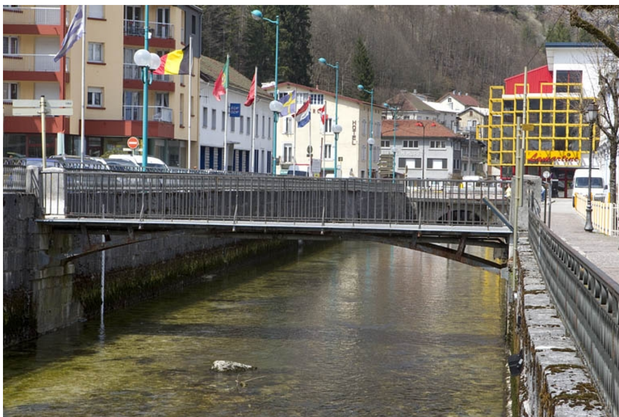
Passerelle aval, vue de l'amont.
