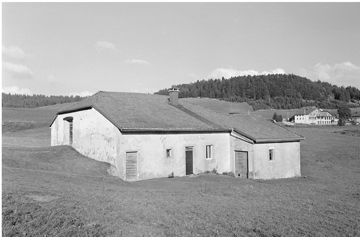
Façade antérieure et face nord-ouest.
