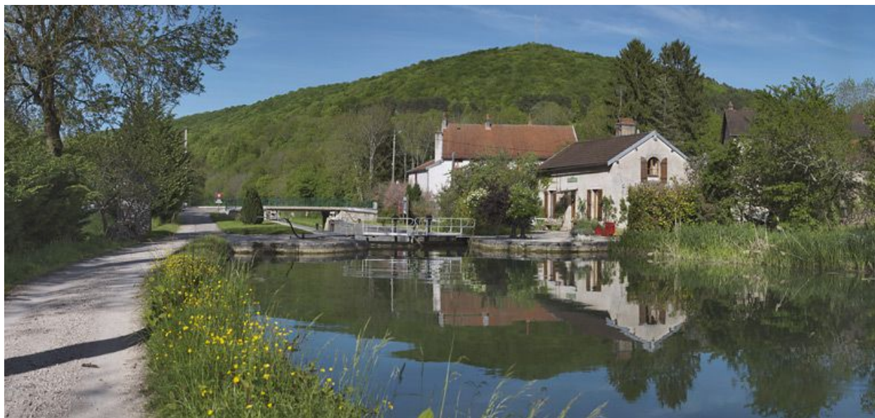
Vue d'ensemble de l'amont du site d'écluse.
