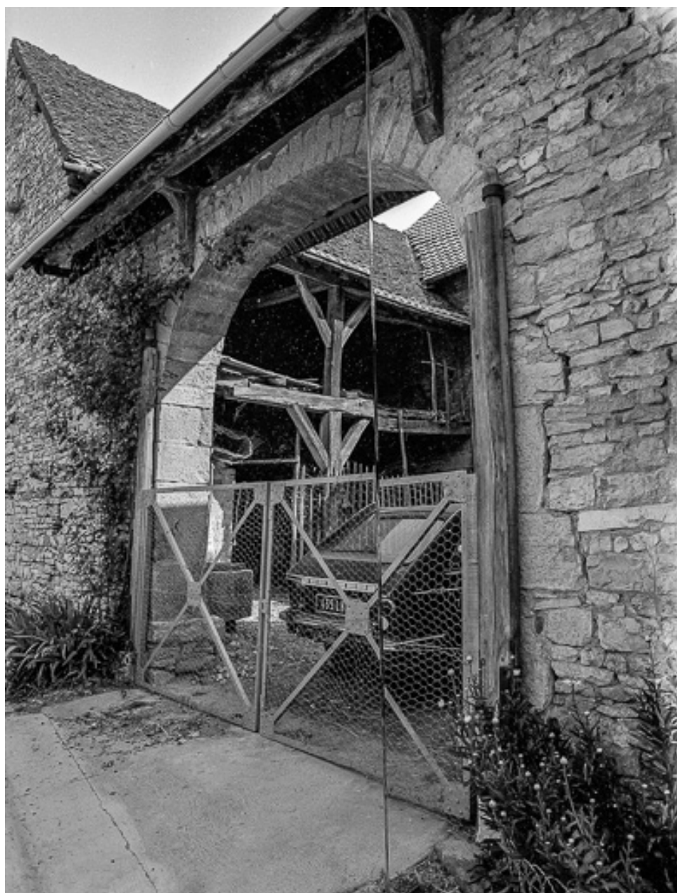
Cour intérieure, côté gauche : remise.
