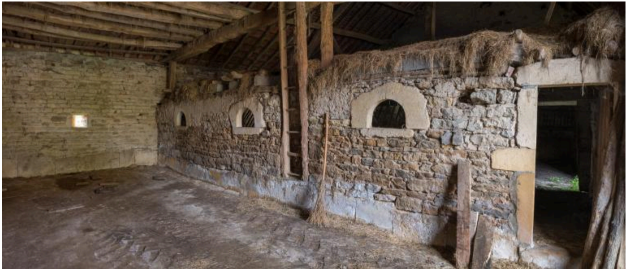
Vue intérieure de la grange (remise, mur de séparation avec l'étable, percé de feurons, et fenil)
