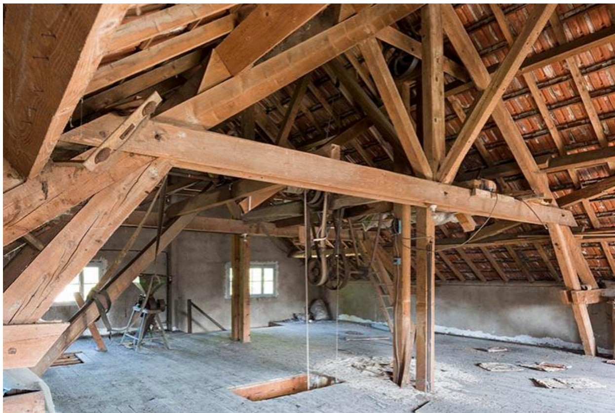
Vue d'ensemble de l'étage en surcroît
