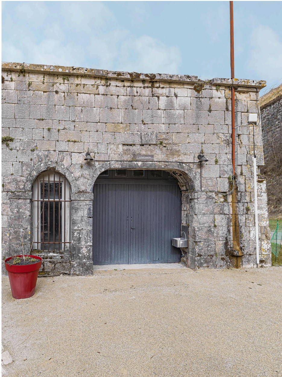
La casemate du corps de garde.
