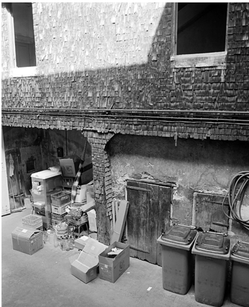
Escalier dans la cour, partie inférieure.
