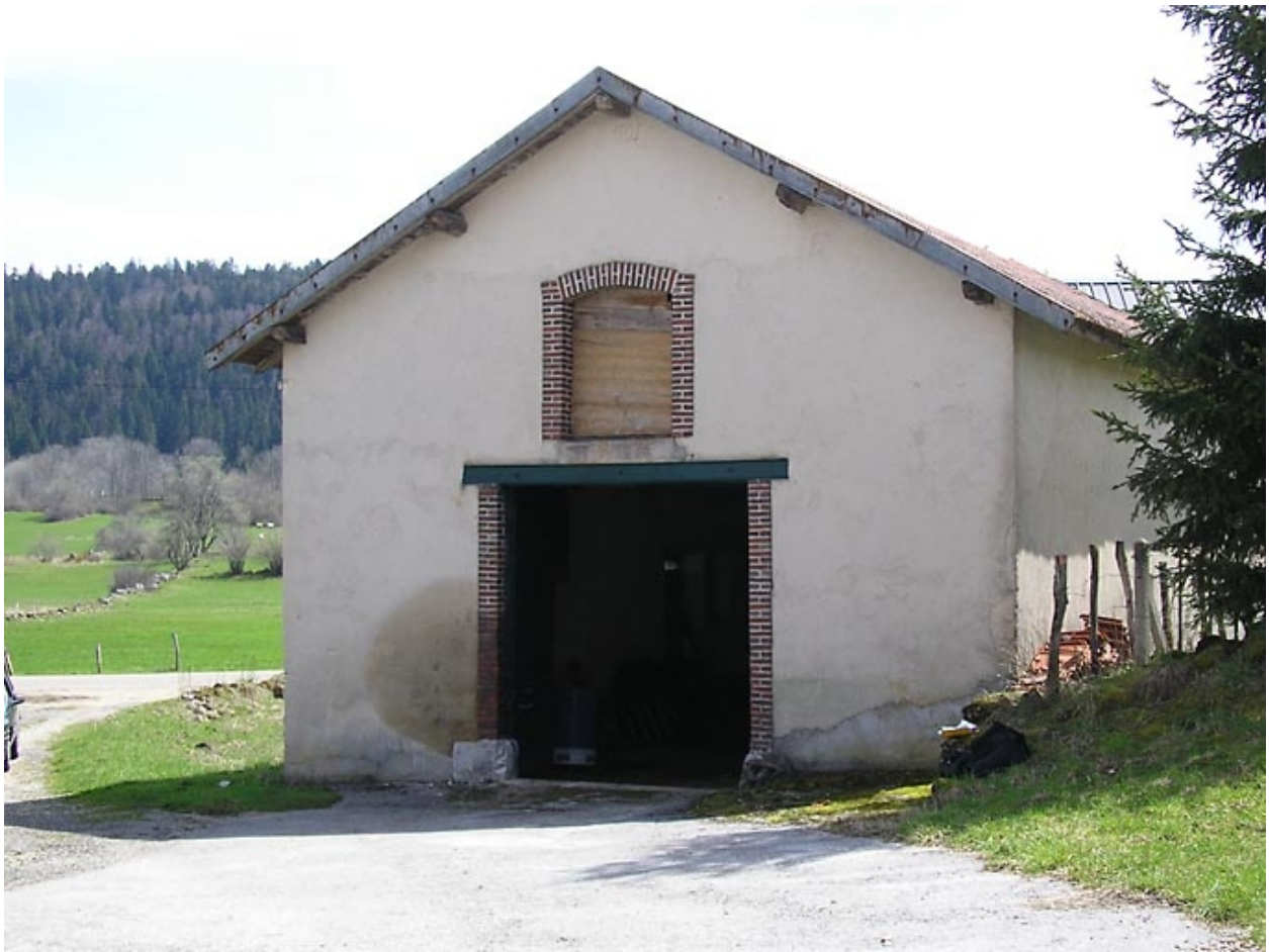
Vue de l'entrée du hangar agricole.
