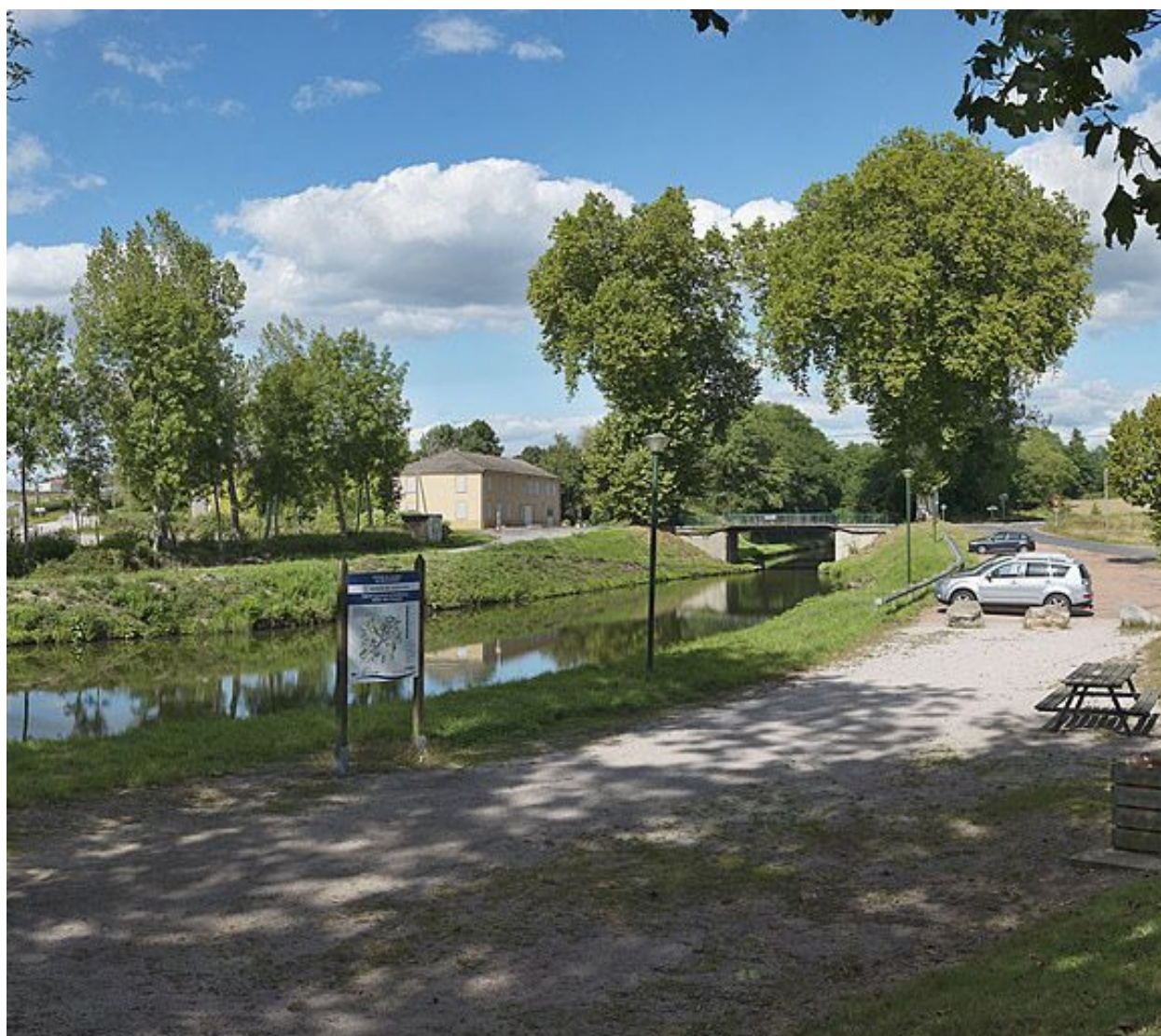
Le pont vu d'amont.
