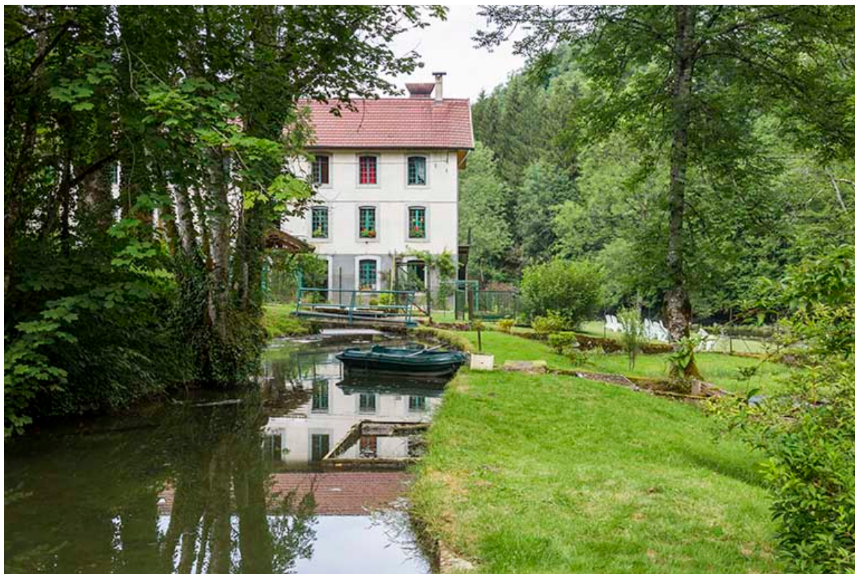
Moulin, façade antérieure : bief d'amenée.
