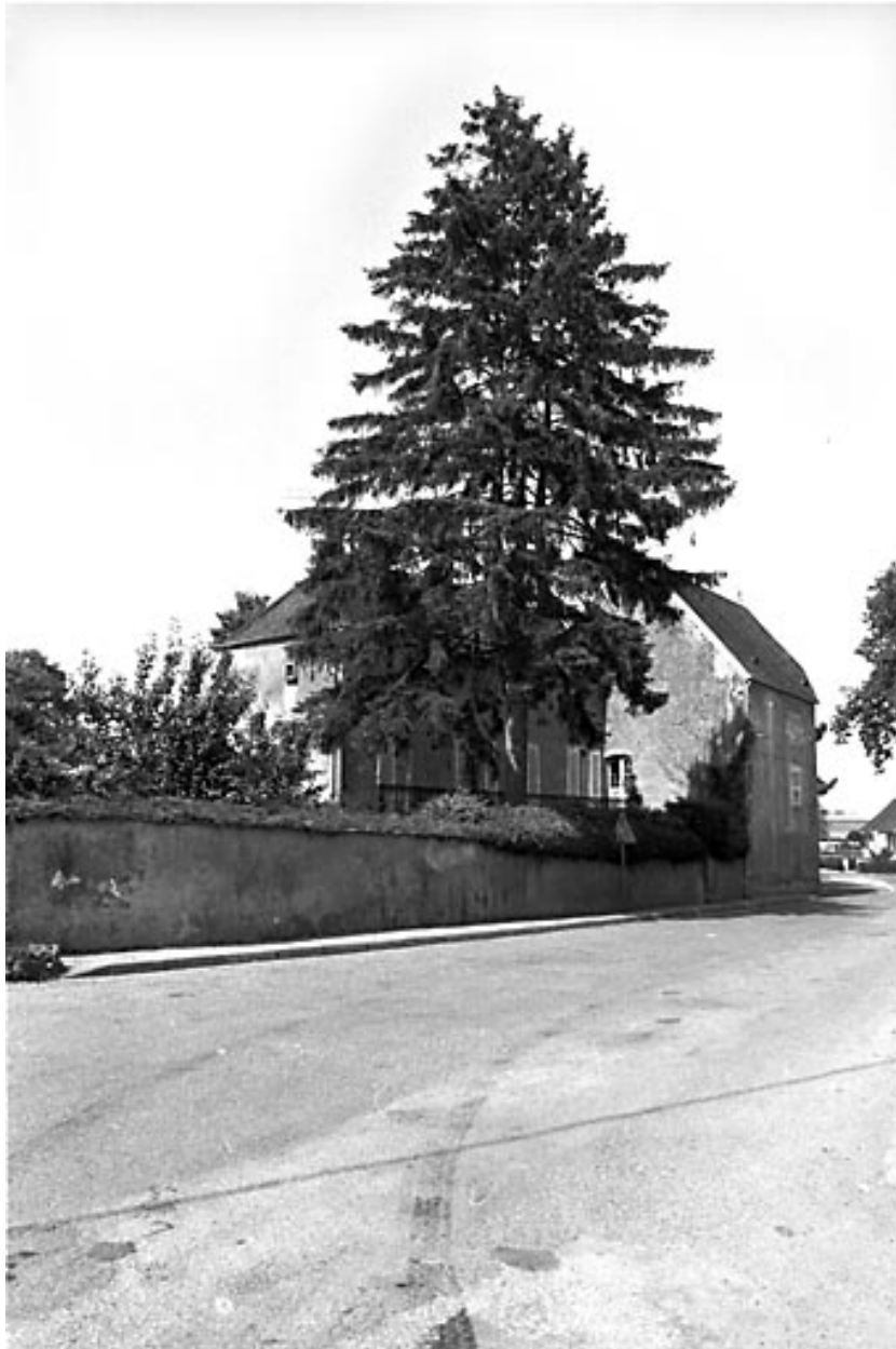
Maison située rue des Promenades : vue d'ensemble.
