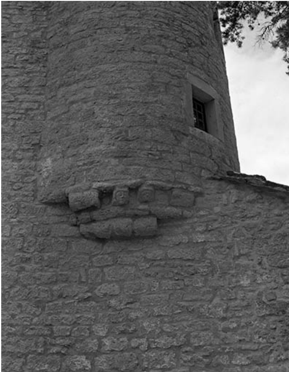
Encorbellement de la tourelle de l'angle nord-est
