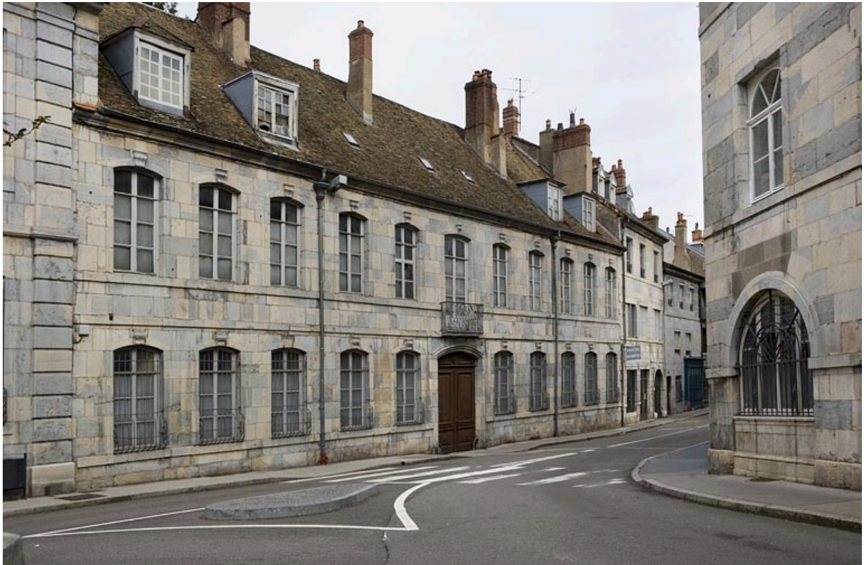
Vue d'ensemble de la façade de trois quarts gauche.
