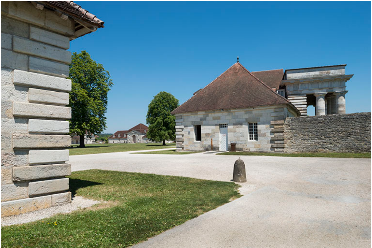
Bâtiment d'entrée vu de côté.
