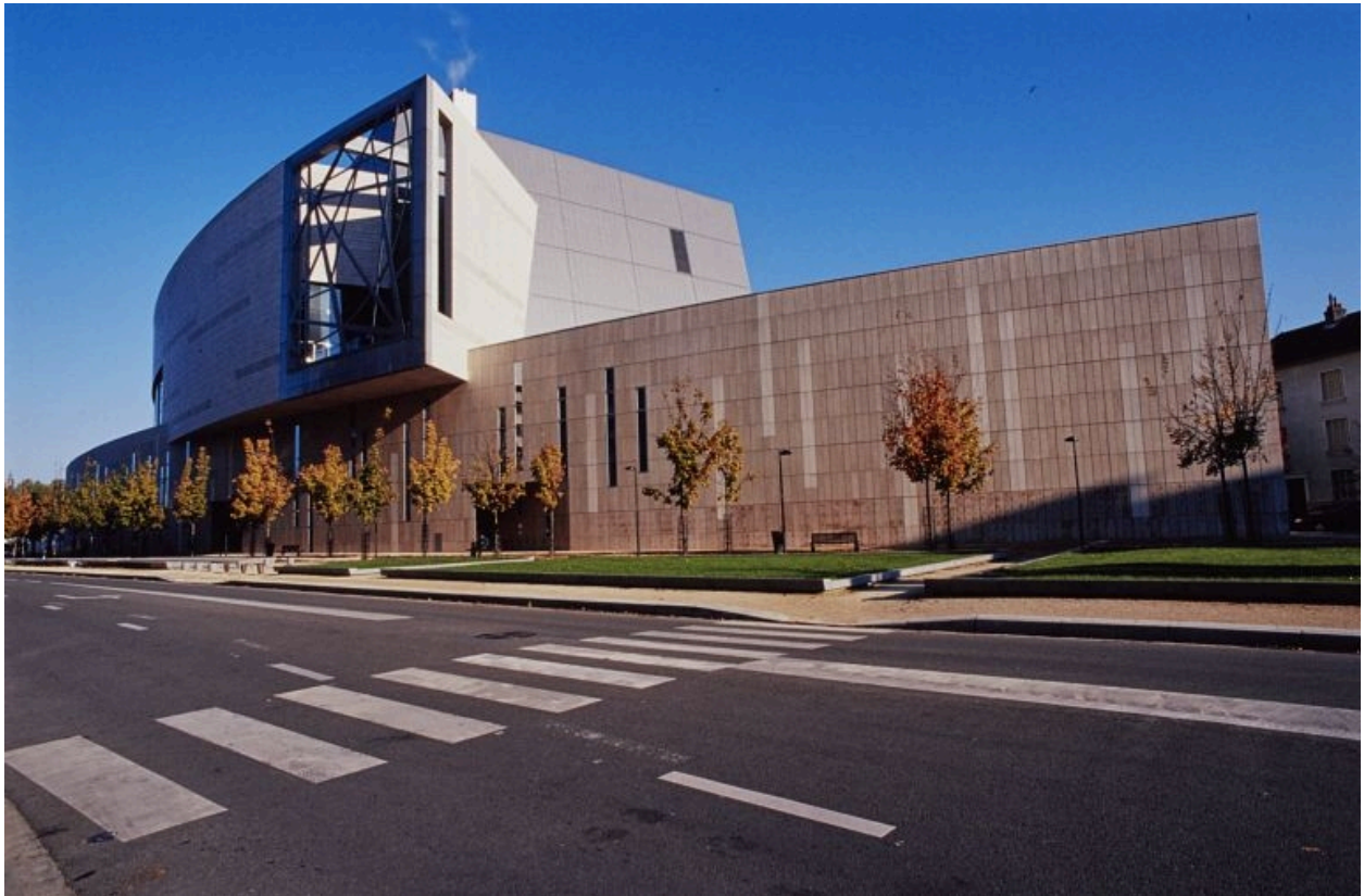
Elévation latérale, boulevard de Verdun, en 2001.
