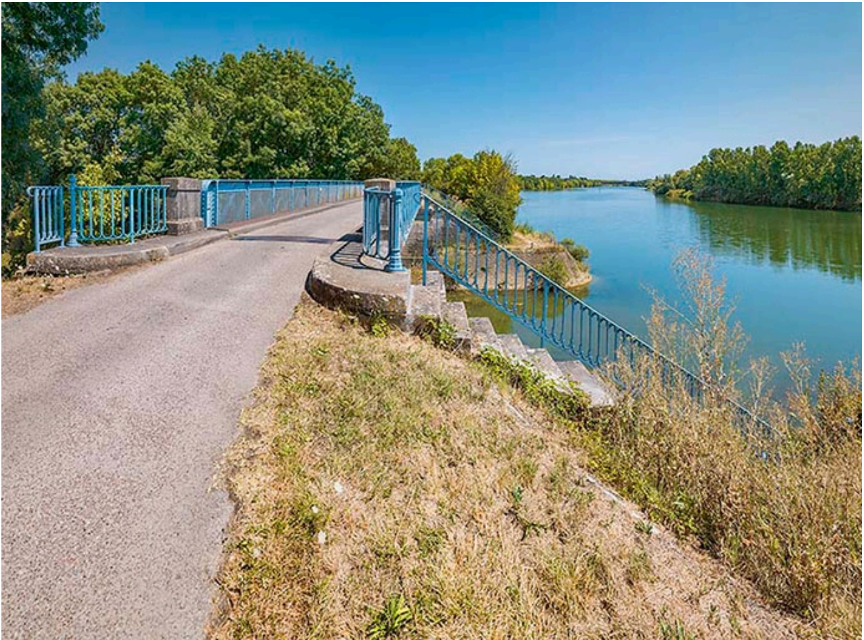
Le pont sur la Dheune, vu d'aval. Escaliers.
