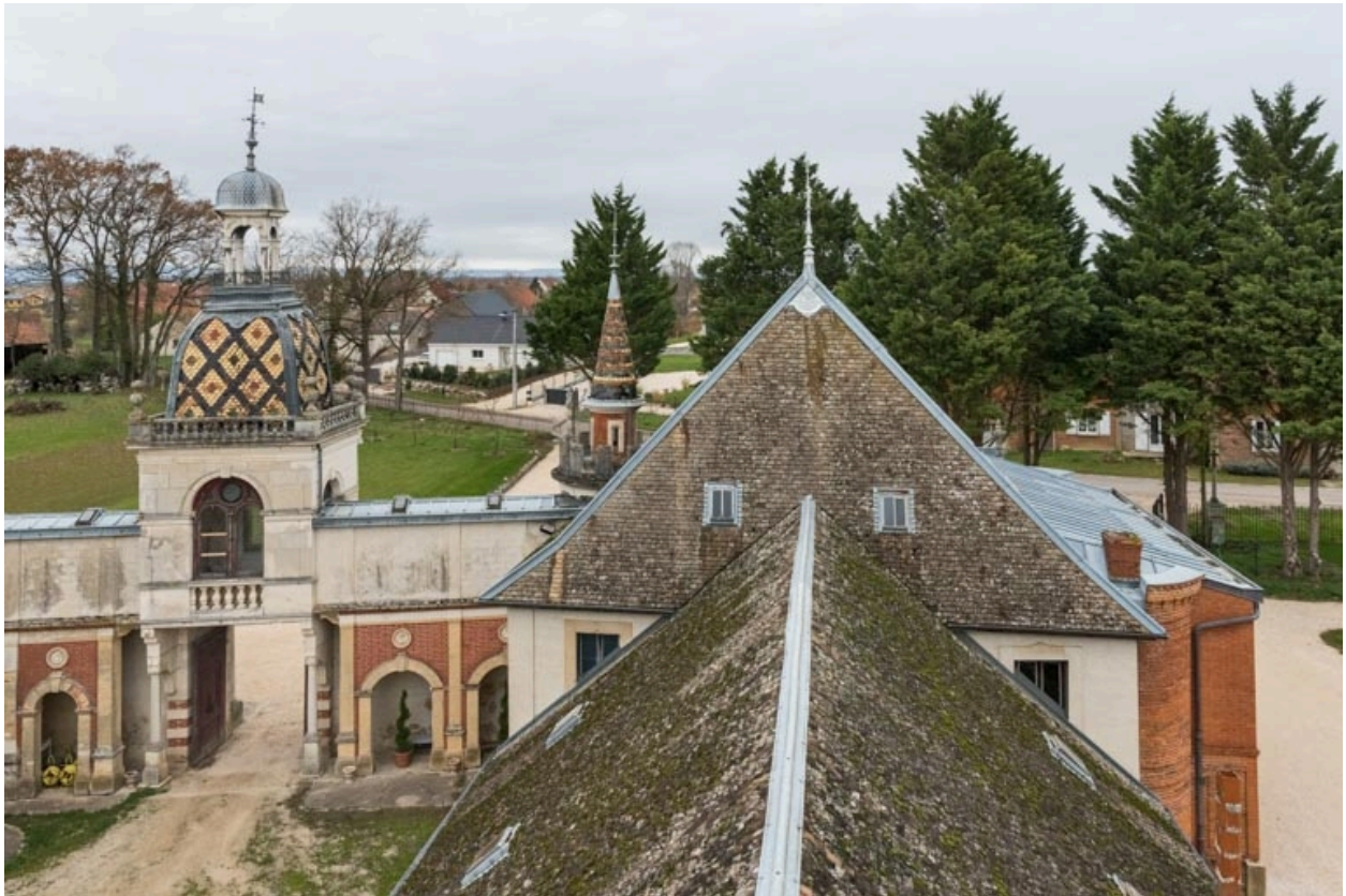
Toitures du corps nord et du corps central, depuis le "Donjon".
