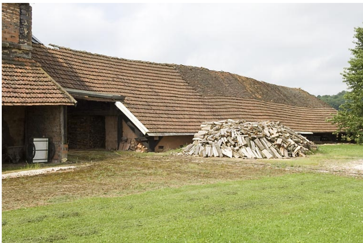
Le séchoir vu depuis le nord-est.
