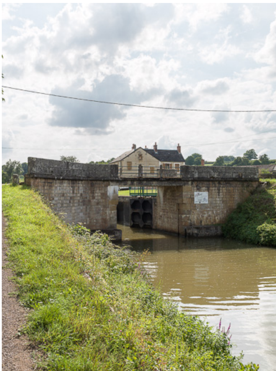
Vue d'ensemble du pont.
