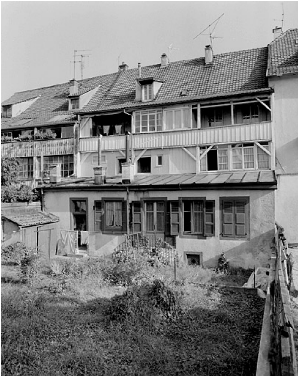
Maison 45, rue Georges-Clémenceau. Galeries ouvrant sur le jardin. 18e ou début 19e siècle.
