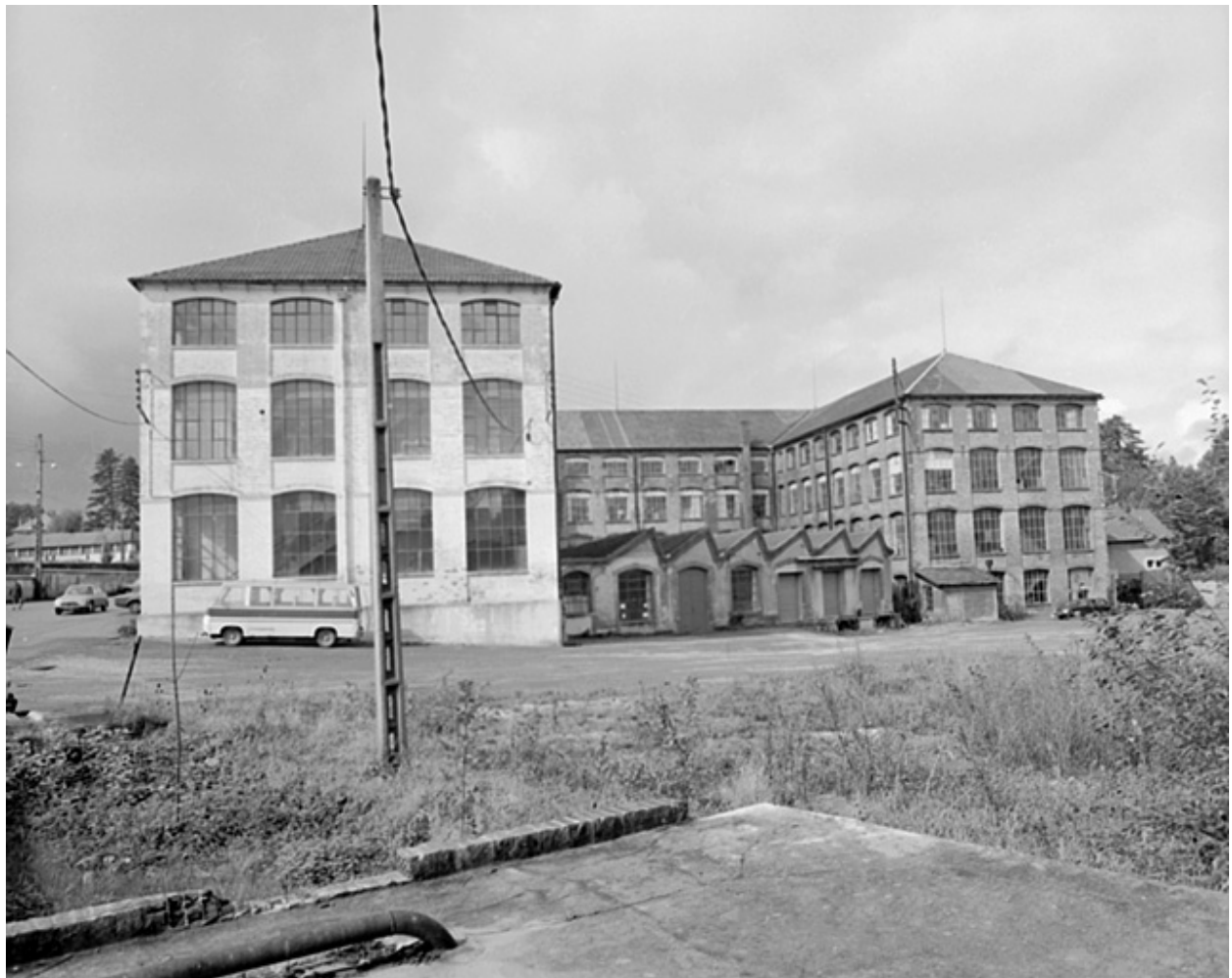
Vue depuis l'est en 1981.SRI. Enquête régionale sur les bâtiments industriels (1979-1981).
