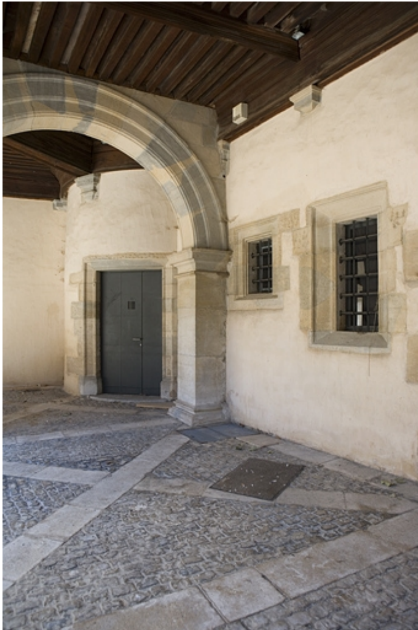
Détail d'une porte d'un escalier en vis dans l'angle nord du portique.
