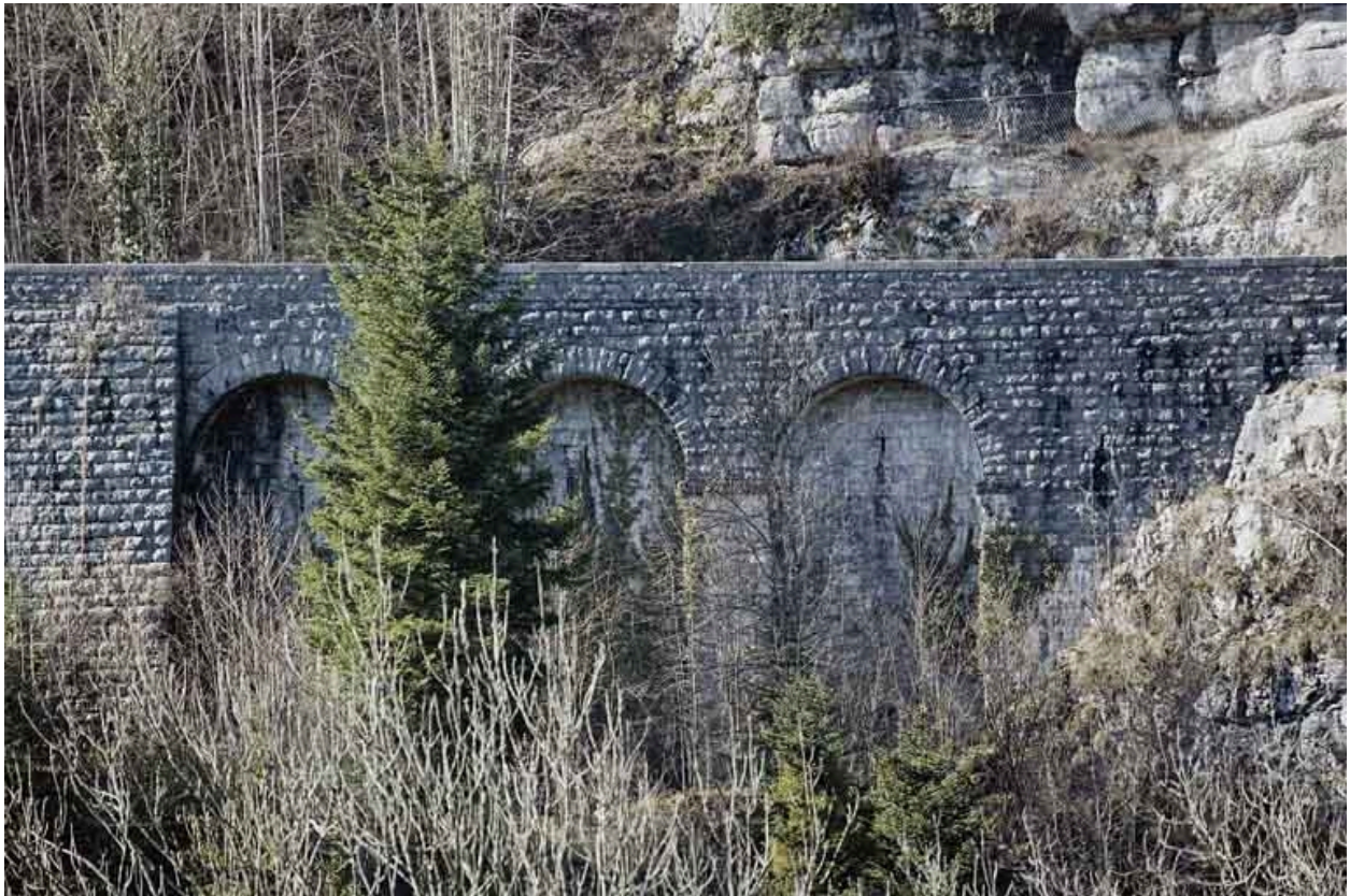
Premier mur à arcades : 3 arches du côté Andelot-en-Montagne.
