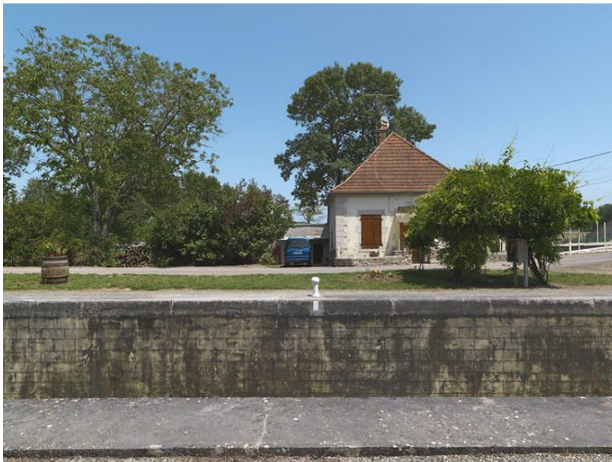
Maison éclésièr vue de face.
