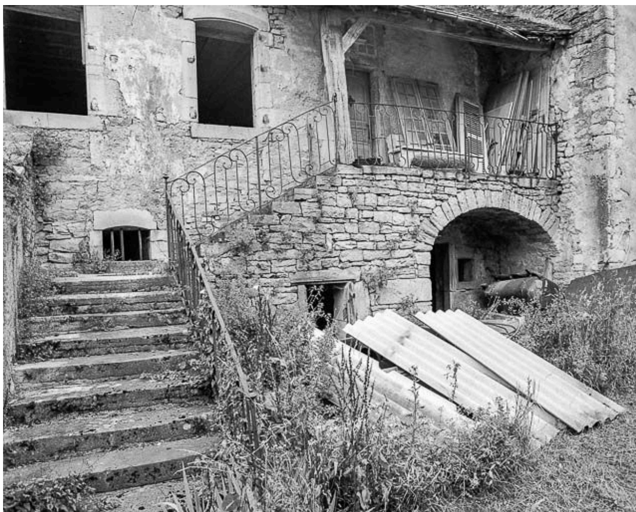
Détail de l'escalier.
