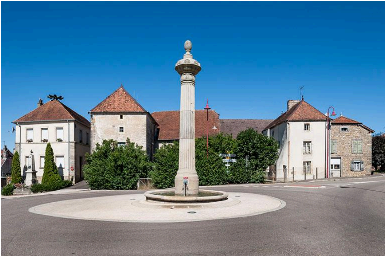
Place de la Résistance, fontaine-colonne. Alignement de maisons, ancienne maison commune, deux fermes en L symétriques.
