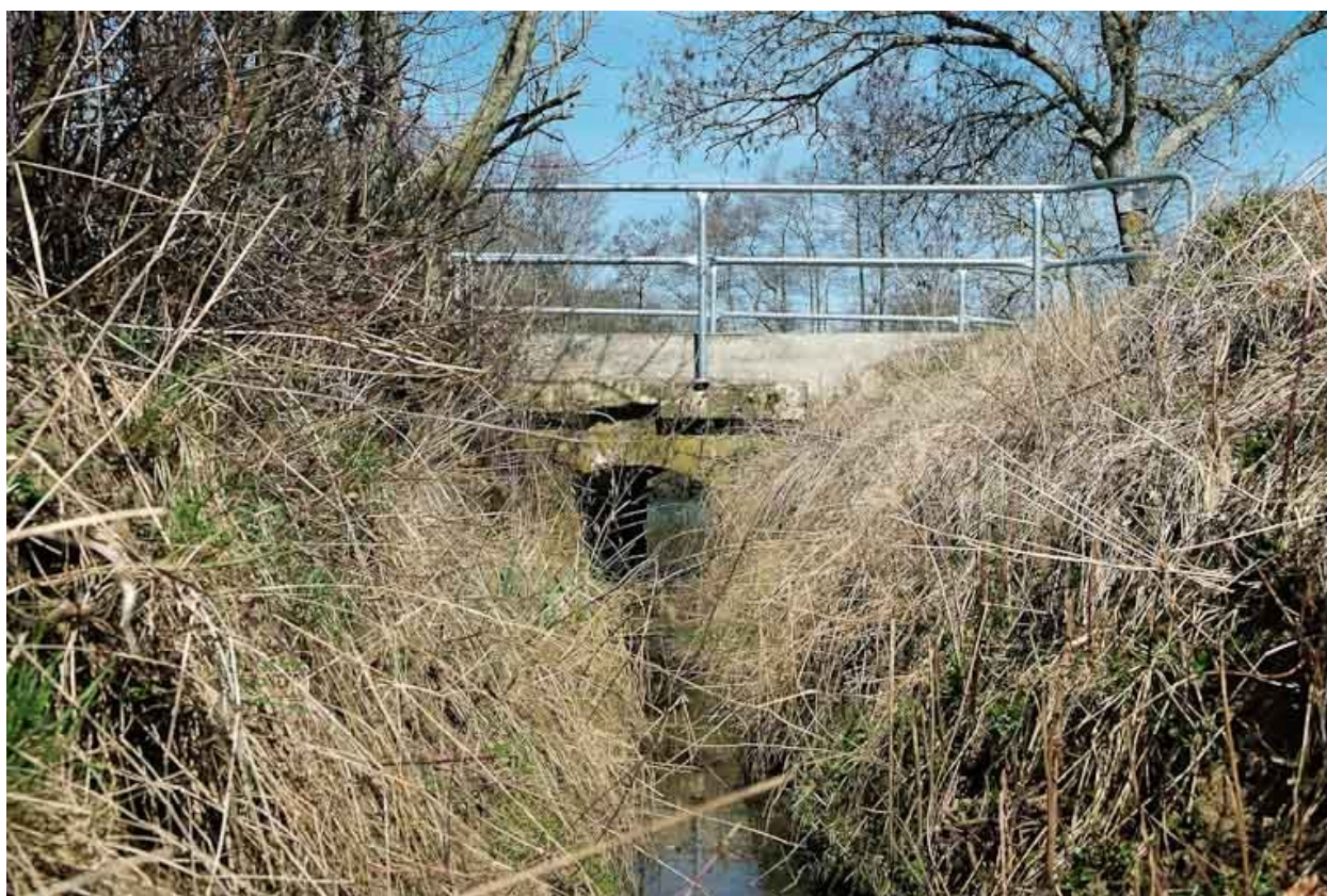
Ponceau, vue rapprochée.
