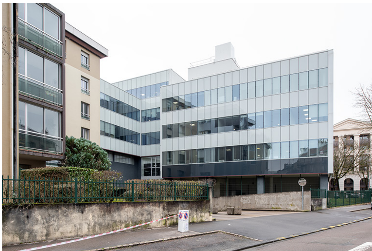
Façade sud-est, partie donnant sur la rampe d'accès, rue Prieur-de-la-Côte-d'Or.
