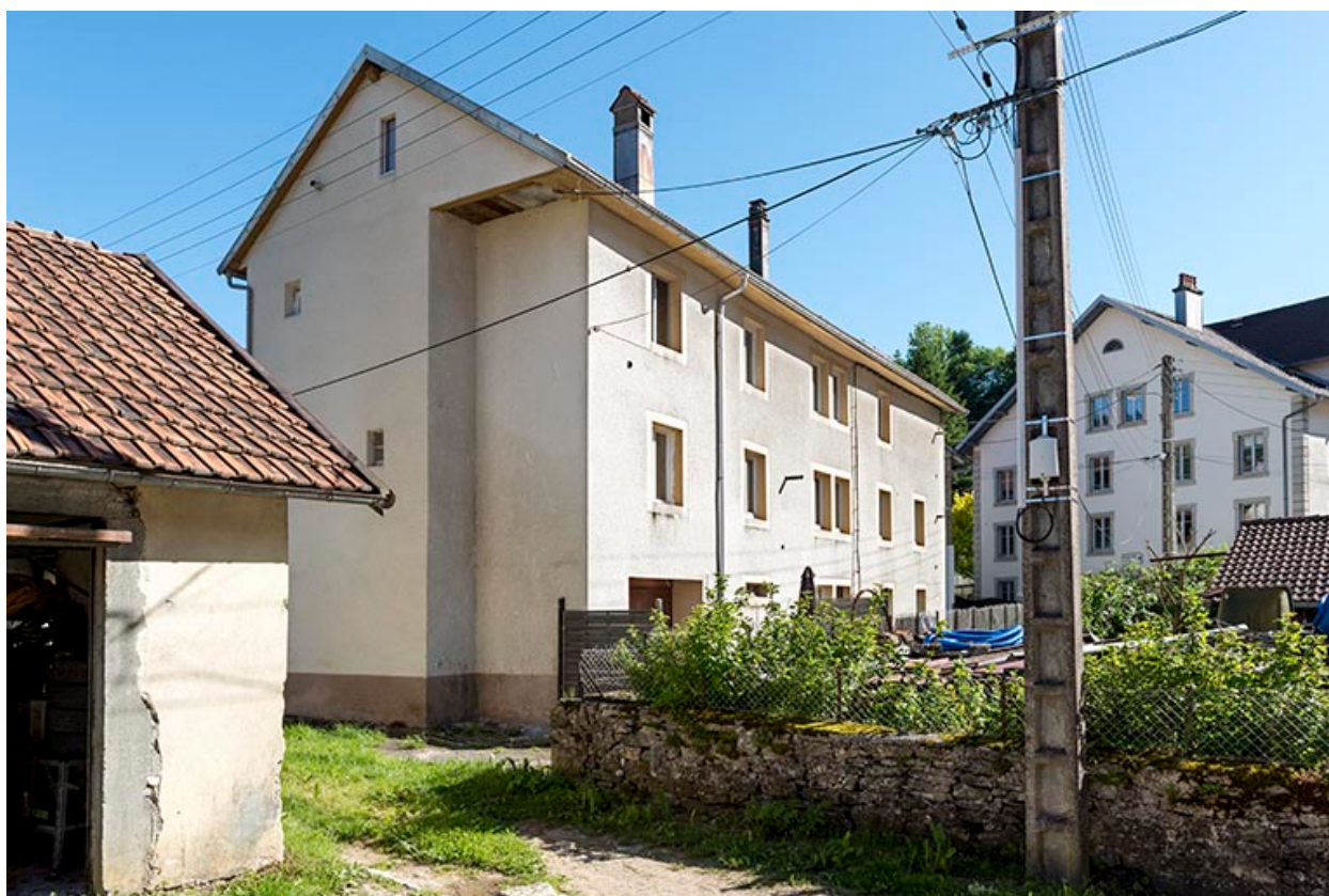
Façades postérieure et latérale droite.
