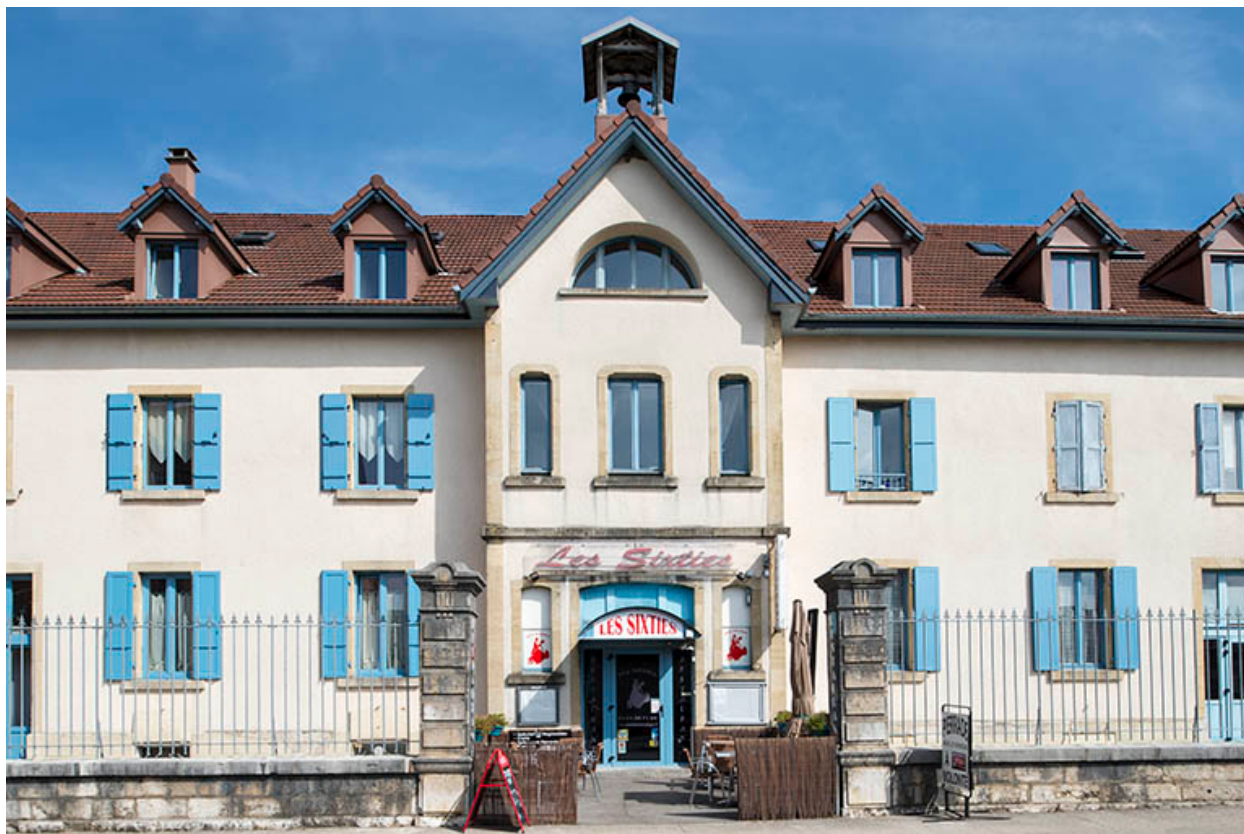
Partie centrale du bâtiment de la distillerie.
