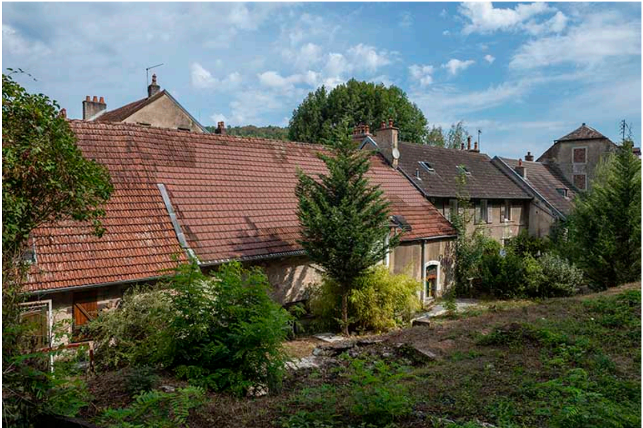
Façades sud des écuries, remises et logements.
