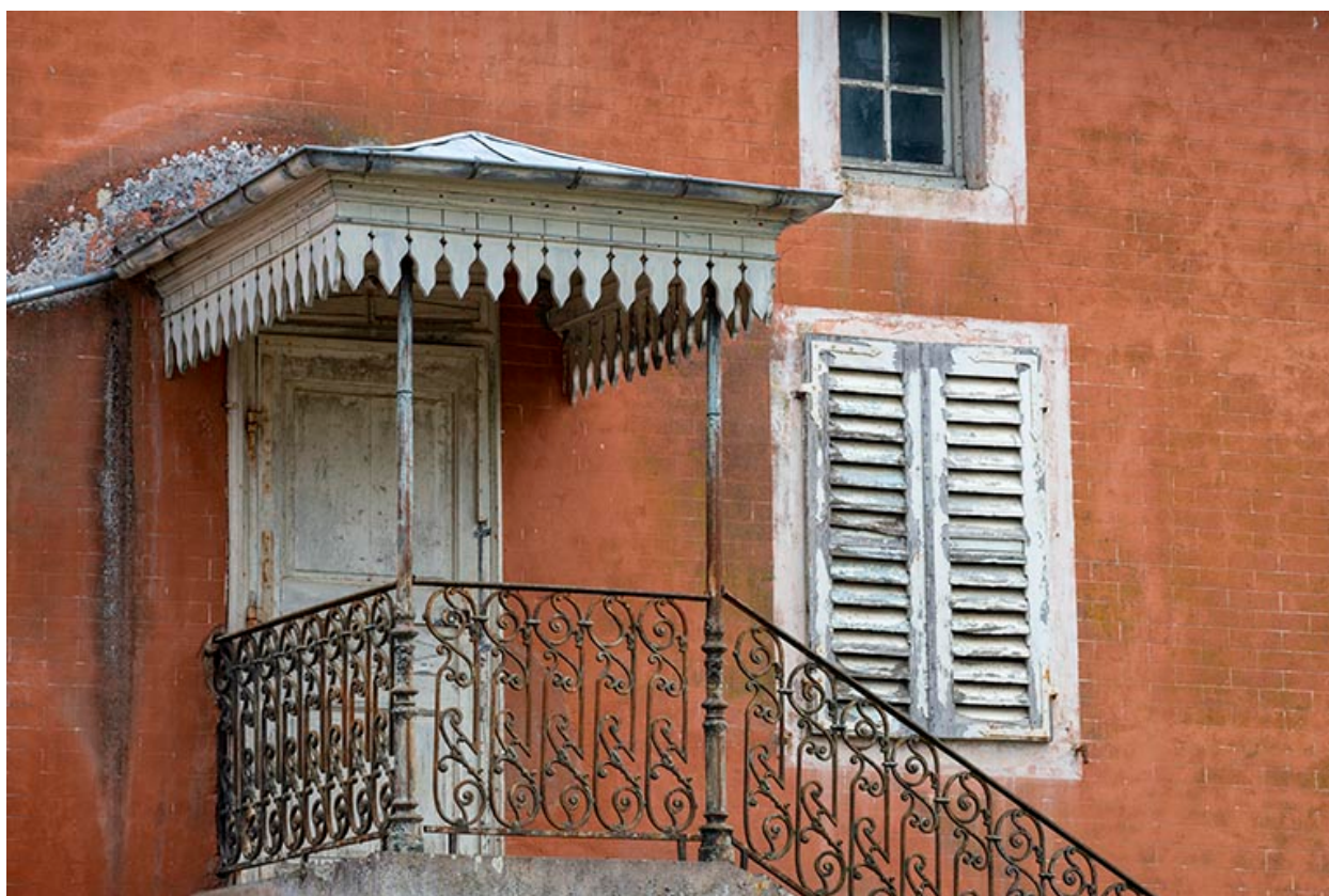
Façade nord, perron.
