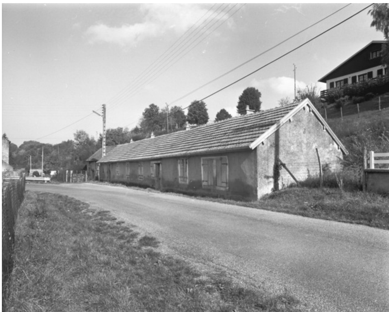
Logement ouvrier de la forge de Petit Baignes en 1989.
