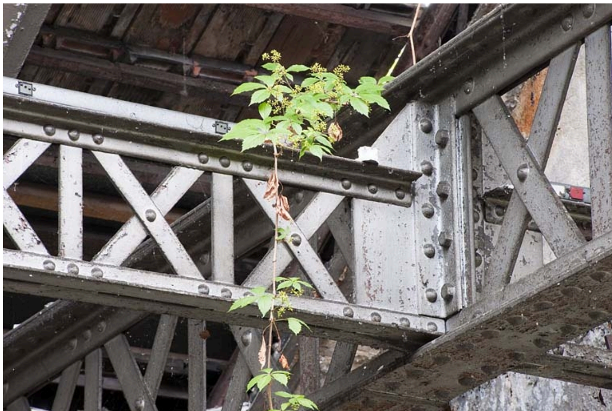
Détail de poutrelles à treillis.
